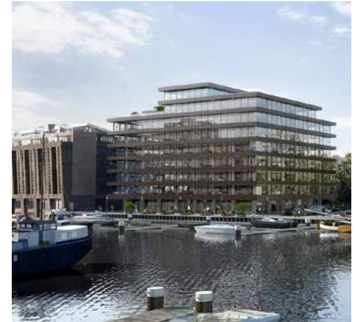
Kantoorgebouw De Walvis in Amsterdam.
