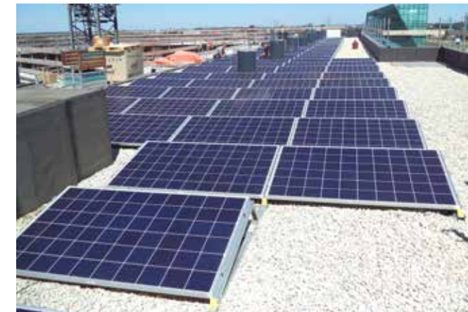
Een deel van de elektriciteit wordt opgewekt door zonnepanelen op het dak.
