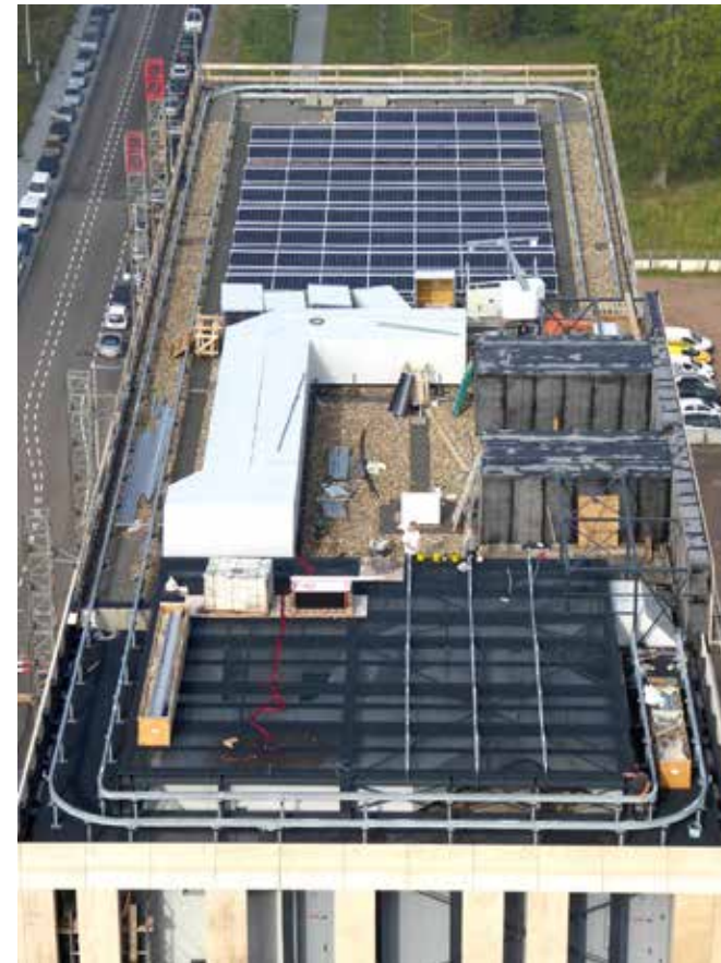
Dak bovenste verdieping met PV-panelen.
